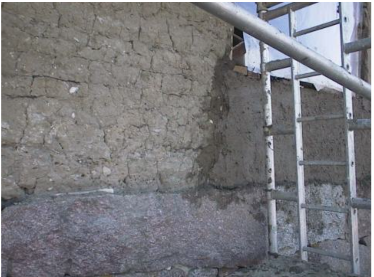
Rakennuksesta on poistettu irtoillut kalkkirappaus ja pinta rapataan uudelleen savilaastilla. Rappaus työn toteutus on esitelty kohdassa rappauslaastiohje 2.
